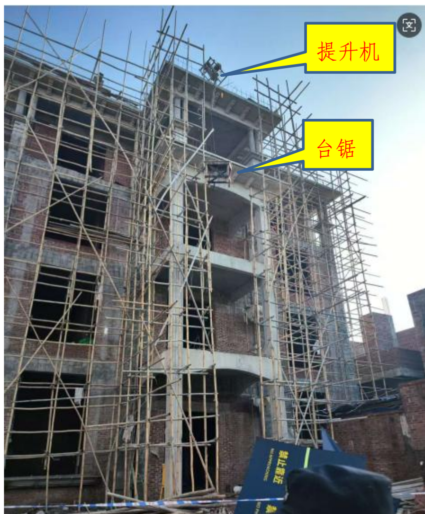
图 7 事发时施工现场情况图
