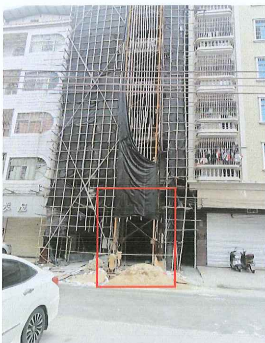
图1 物料提升机入口
