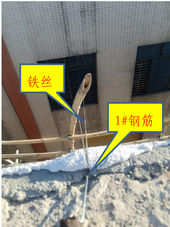
图 4 1#钢筋固定点情况
