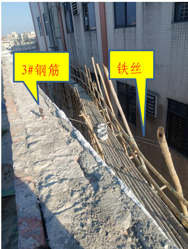
图 6 3#钢筋固定点情况
