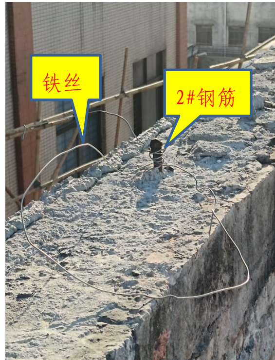
图 5 2#钢筋固定点情况
