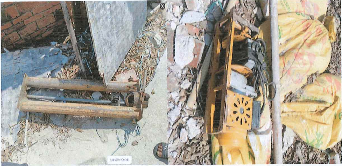
图3、图4 物料提升机情况图
