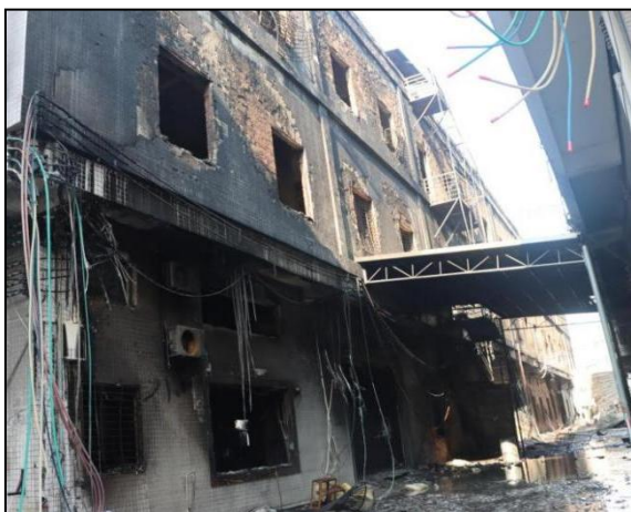
图10 *2 公司 1 号厂房南面墙
