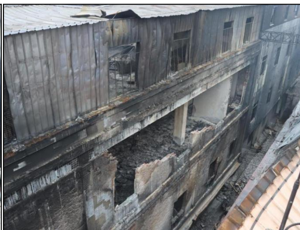
图11 *2 公司 2 号厂房北面墙
